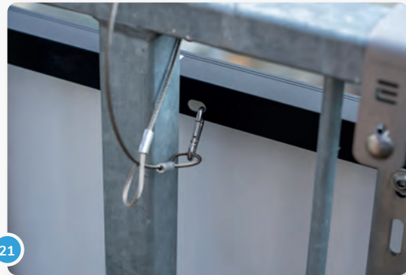
21 Achte dabei darauf, dass die Schließe des Karabiners nicht zum Modulrahmen zeigt.
