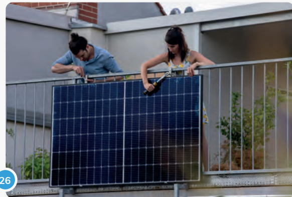
26 Jetzt kannst du ein noch einmal alle Schrauben kontrollieren und bei Bedarf fester anziehen...
