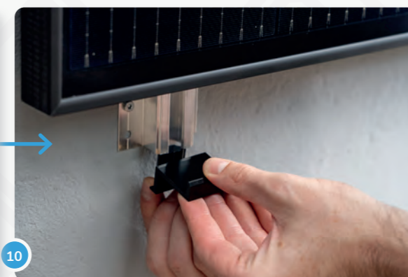
10 Bringe nun das Panel in die gewünschte Position und lass dir beim Anbringen der Klemmen von jemandem helfen.
