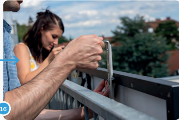
16 Hänge nun die beiden Haken samt Panel am Geländer auf. Bitte lass dir dabei helfen!
