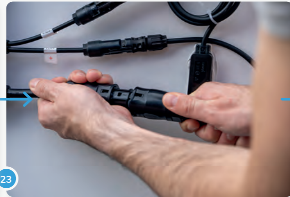
23 Wenn du dich für LightMate G+ entschieden hast, kannst du jetzt die beiden Wechselrichter miteinander verbinden.
