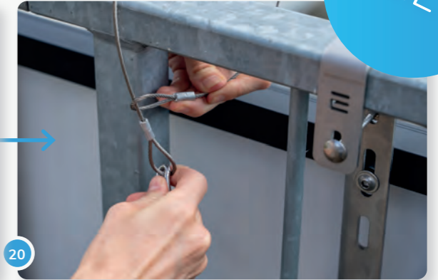
20 Befestige jetzt das mitgelieferte Sicherheitsseil mit Karabiner mittig am Handlauf und am Panel.
