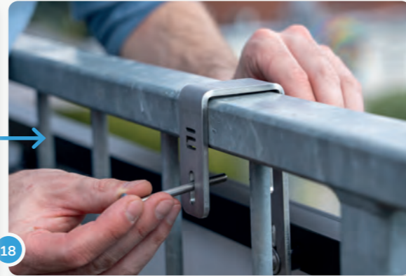
18 ...dann die langen Schrauben unterhalb des Handlaufs durchstecken...
