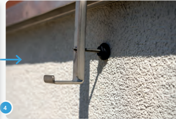
4 Schraube dafür den Abstandshalter in eine der unteren drei Bohrungen um die Position des Panels auszurichten.
