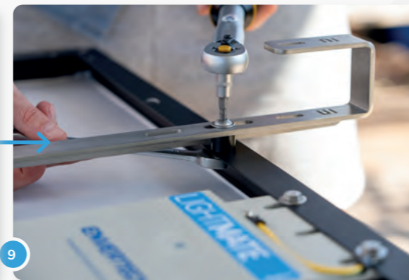
9 Bitte fixiere die Haken dann mit den Schrauben und Sicherheitsmutter am Panel. Achte dabei auf das richtige Drehmoment (laut Anleitung),
