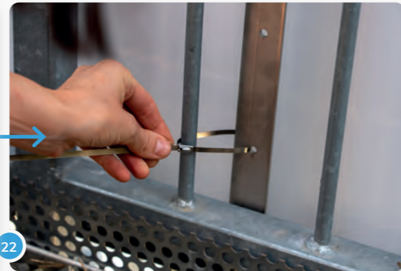
22 Jetzt kannst du die Kabelbinder um das untere Ende der Balkonhaken führen. Zurre sie so fest, dass das Panel nicht mehr schwingen kann.
